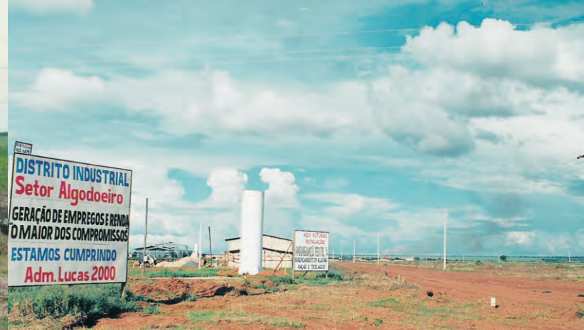
DERRUBADA DE TORRE DO LINHÃO
