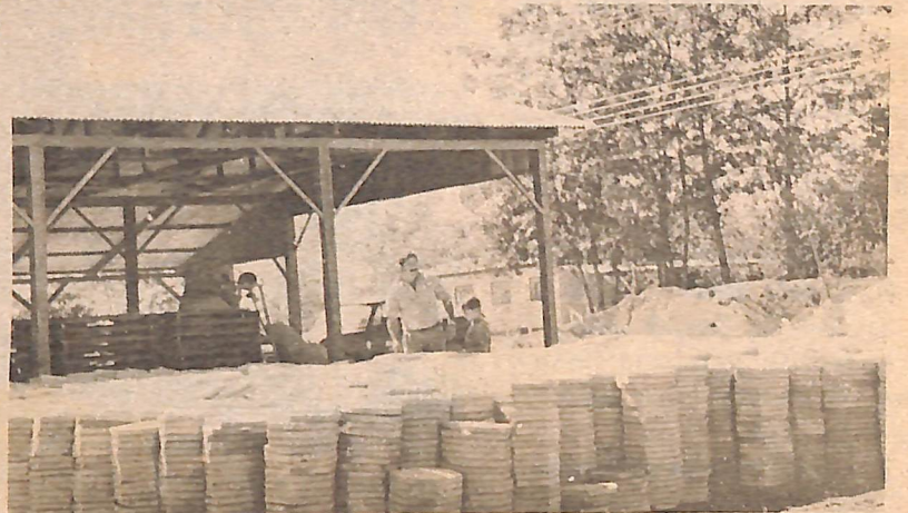
2.000 m2 DE BLOQUETES PRONTOS PARA A CONSTRUÇÃO DE PASSEIOS...
