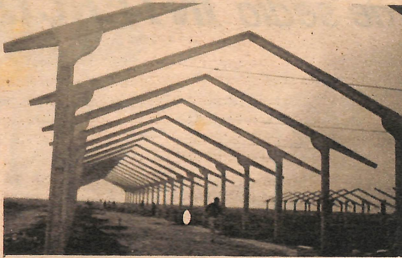
OBRAS DE CONSTRUÇÃO DOS MÓDULOS PARA PRODUÇÃO DE MATRIZES
