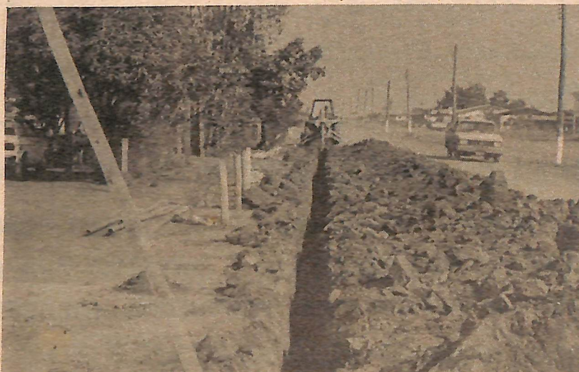
Início das obras de instalação da água
