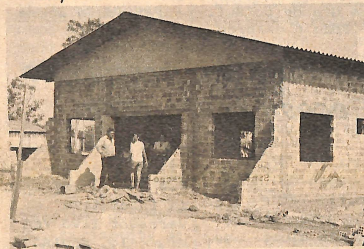
Visita ao prédio da LBA, em construção.
